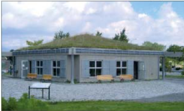
Figure 29 : Toiture du pavillon de service du Domaine Maizerets, Québec.
