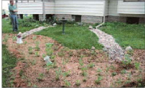
Figure 48 : Gouttières raccordées à un jardin de pluie.
