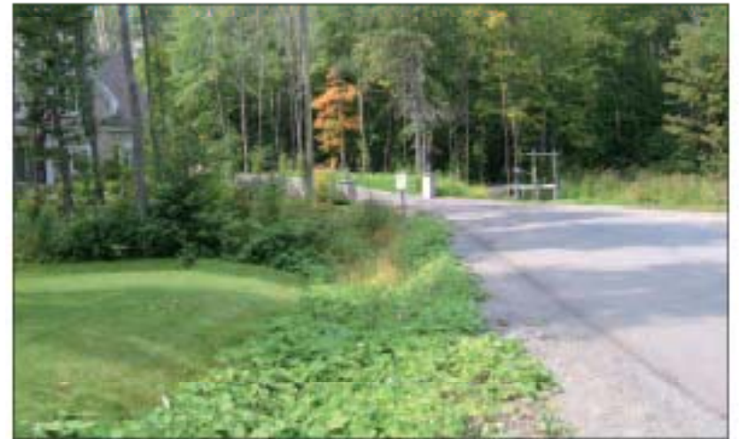
Figure 40 : Fossé végétalisé dans le projet des Clos Prévostois.
